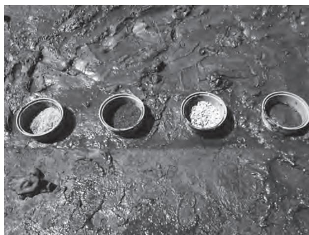
写真5 菊田川における底質改善構造設置(浸透マス)
