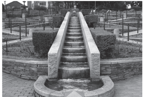
写真7 段差型構造例 (公園の階段式水路)
