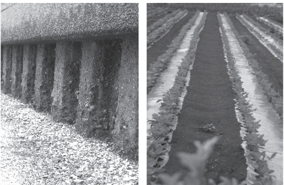
写真4 波型構造例 (鋼矢板護岸と畑)
