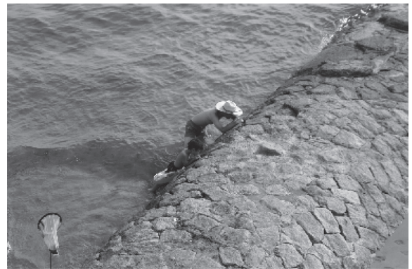
写真6 裂目型構造例 (人工突堤の捨石)
