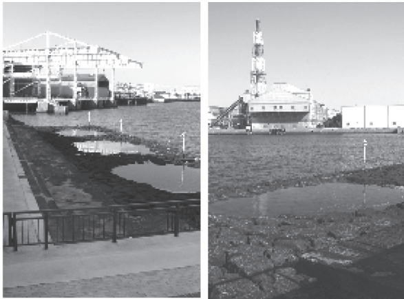
写真2 凹型構造例 (人工タイドプール)
