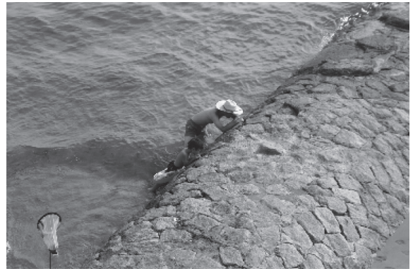
写真6 裂目型構造例 (人工突堤の捨石)
