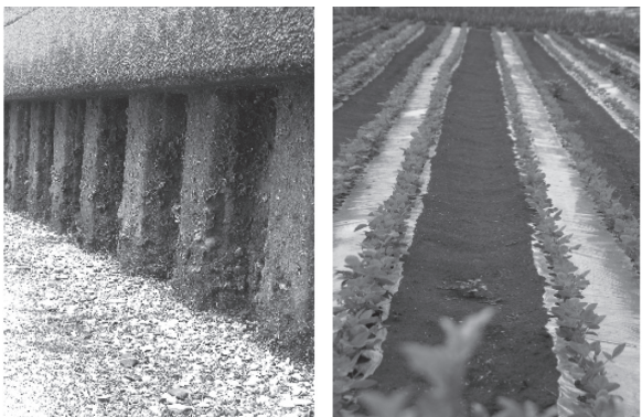
写真4 波型構造例 (鋼矢板護岸と畑)
