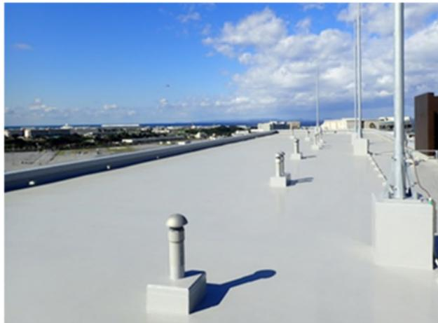
写真 2.1 ウレタンゴム系塗膜防水施工状況
