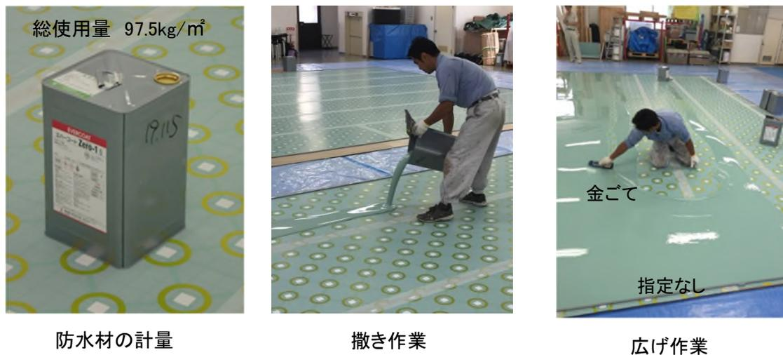
写真 5.1 A 工区 塗布量管理のみの施工手順
