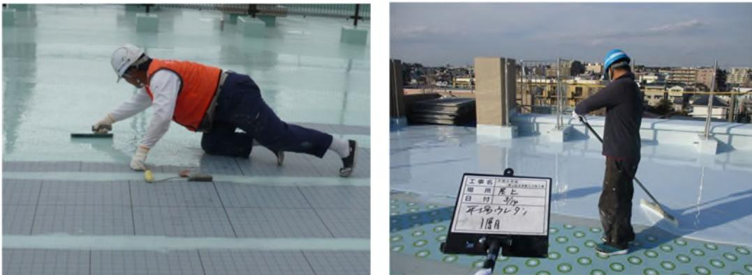
写真 3.1 ウレタンゴム系塗膜防水層平場部の施工状況
