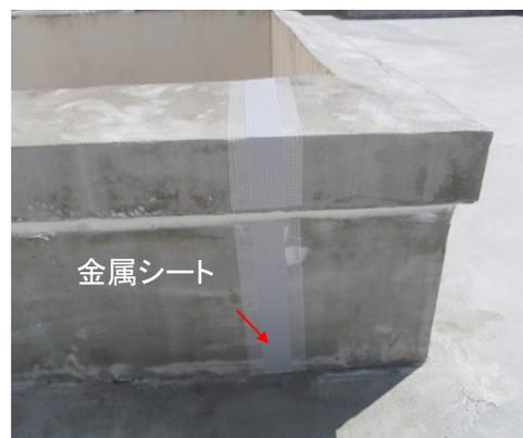
写真11 立上り部金属シート敷設状況
