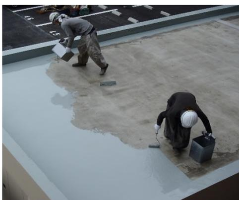
写真1 密着仕様の施工状況
