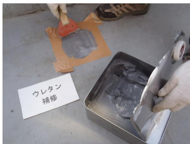
写真3 ウレタン系塗膜防水層の補修状況
