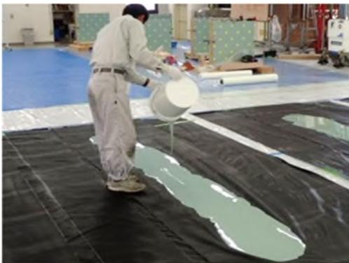
写真 3.6 防水材料の撒き作業状況
