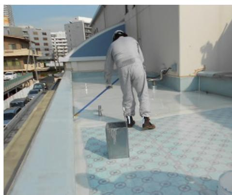
写真2 絶縁仕様の施工状況
