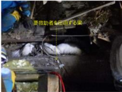
写真 2-1-12 要救助者の状況（上方から撮影）
