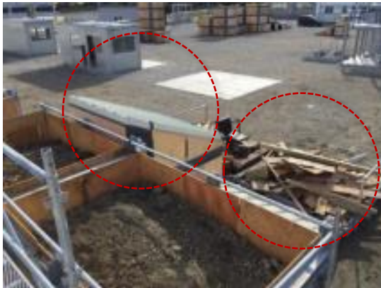
※土砂災害対応訓練エリアへの設置例
