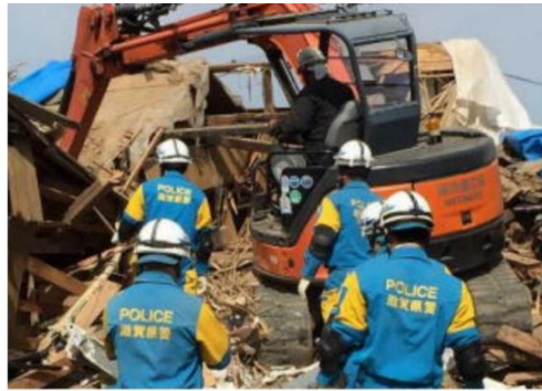
図 2-3-22 建物外から瓦礫を排除して要救助者にアプローチする際の状況（一例） （出典：参考文献 13）
