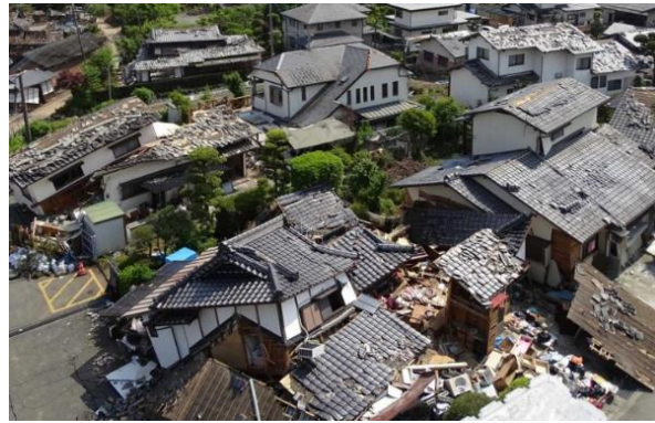
図 2-2-5 益城町における建物倒壊状況 （出典：参考文献 13）
