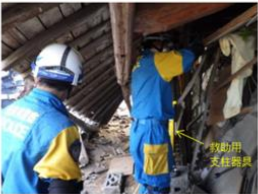
写真 2-1-14 倒壊建物外の救助用支柱器具設置箇所 （設置作業中）
