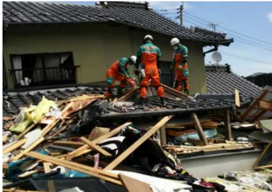
図 2-3-19 1階の屋根から要救助者にアプローチする際の状況（一例） （出典：参考文献 13）
