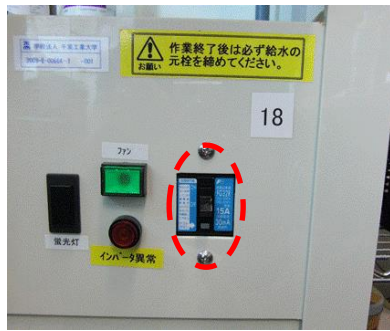
図 3.15 ドラフターのブレーカ
