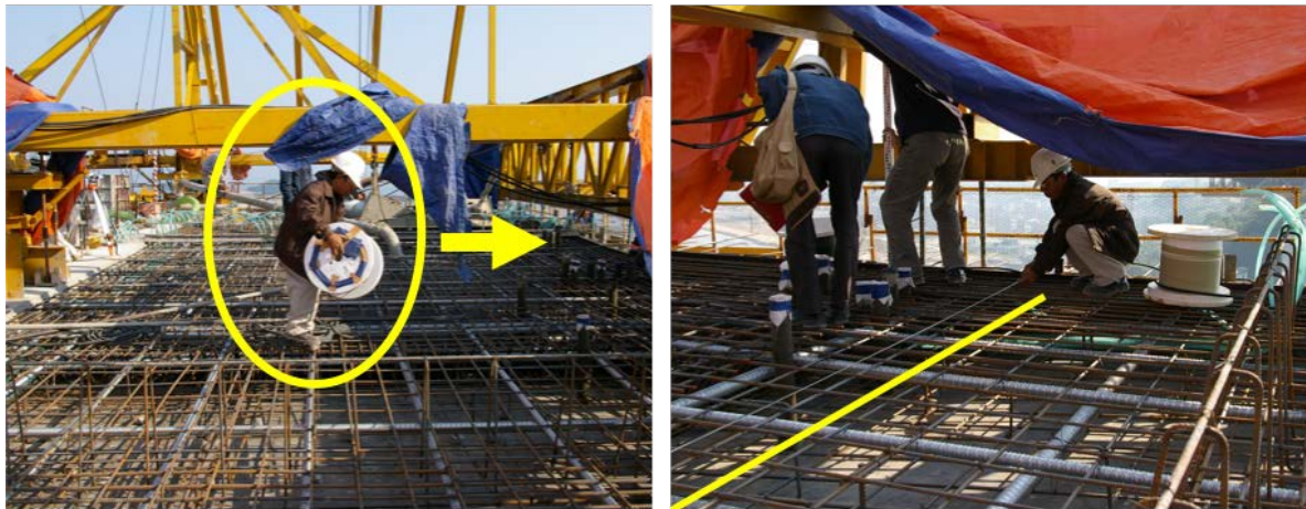
図 2.21 主桁上床版への光ファイバセンサの設置状況
