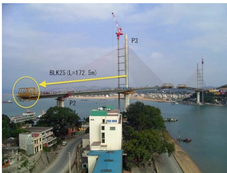
図 2.28 主桁施工状況（ブロック 25）
