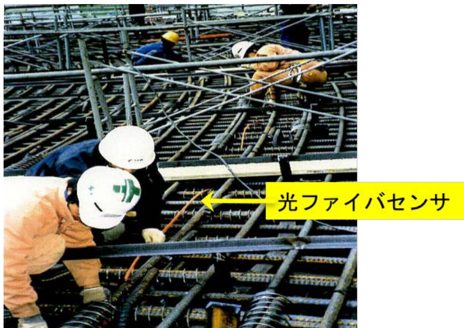
図 2.6 光ファイバ分布温度計測の LNG タンク底版への適用（センサ設置状況）
