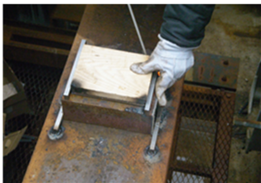
(a) 高さ調整材設置状況
