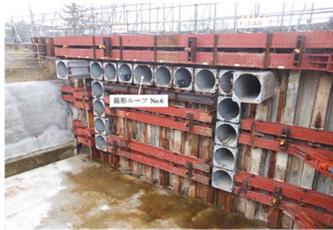
写真-5.1 逐次対策法を適用する箱形ルーフ No. 6
