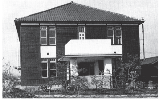
図12 千葉工業大学津田沼校舎本館 19)
