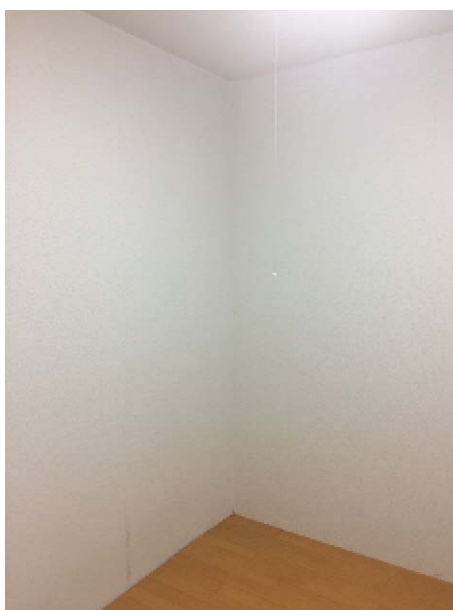
写真 4-3 施工後のチャンバーの内観
