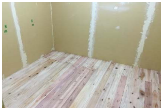
写真 6-1 スギ材を施工した居室大チャンバーの状況
