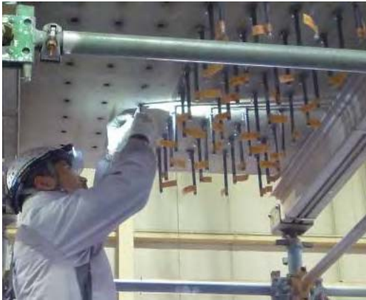
写真 3-3-2 上向き施工状況
