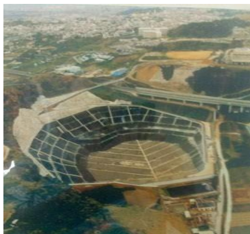
図 4-4-6 植樹前の最終処分場
