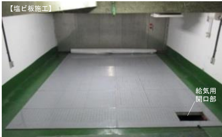
写真3.2 防水層下地作製過程
