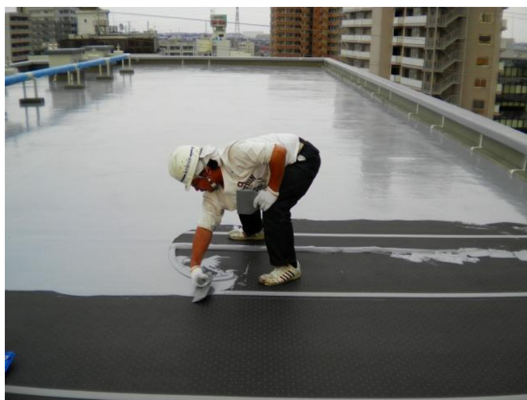
写真2.2 通気緩衝シート張付け時“目止め”工程
