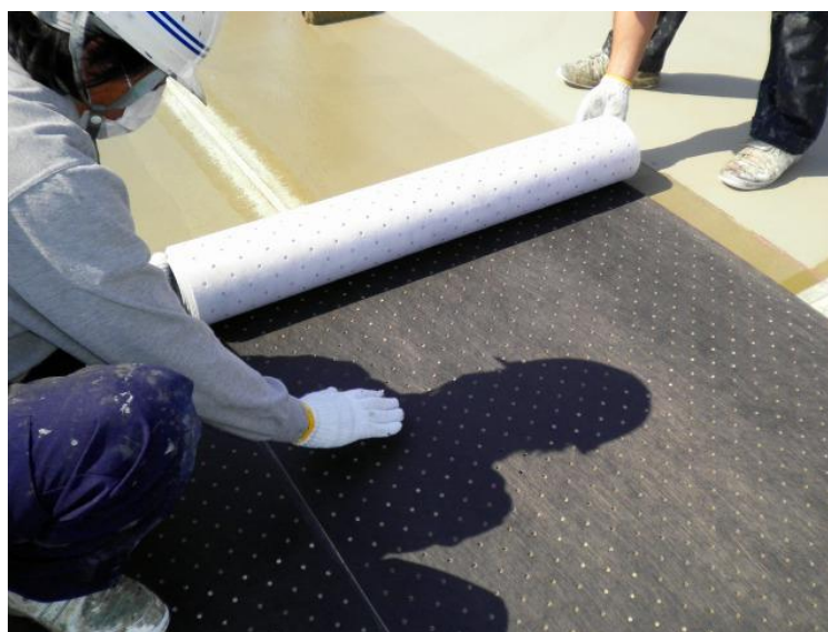
写真2.1 通気緩衝シート（穴あき不織布タイプ）張付け工程
