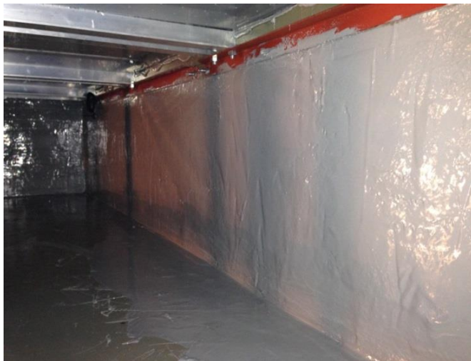
写真3.11 1/2面積加圧時 間仕切り壁
