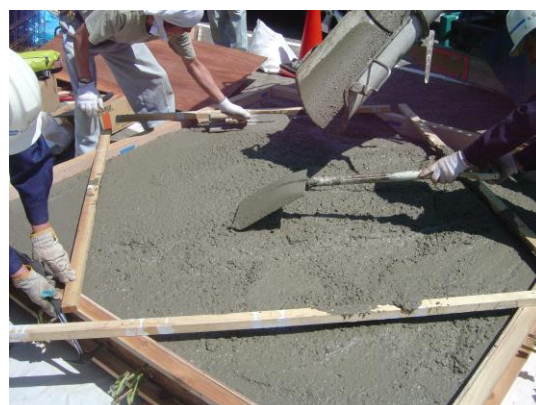
写真2.4 コンクリート打設
