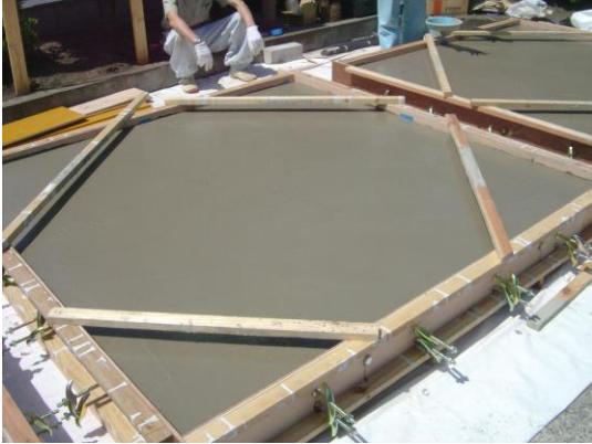
写真2.5 表面金鋳仕上げ
